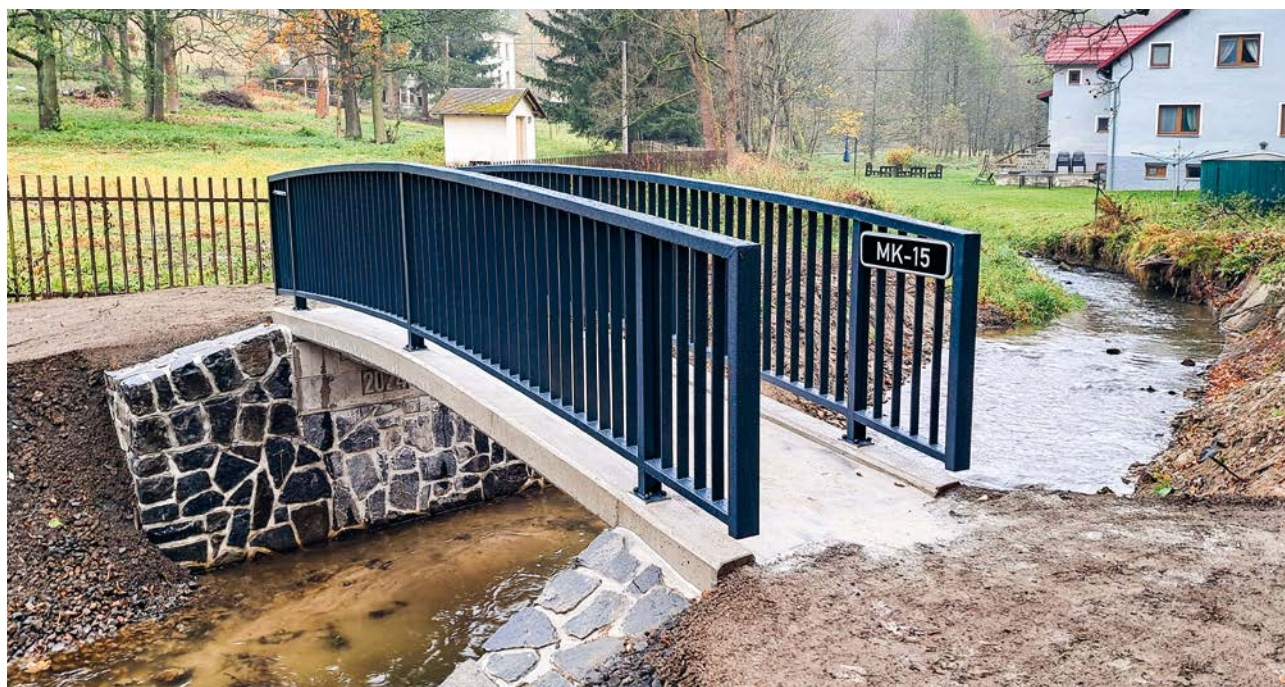
Výstavba nového mostu v Dolní Poustevně
